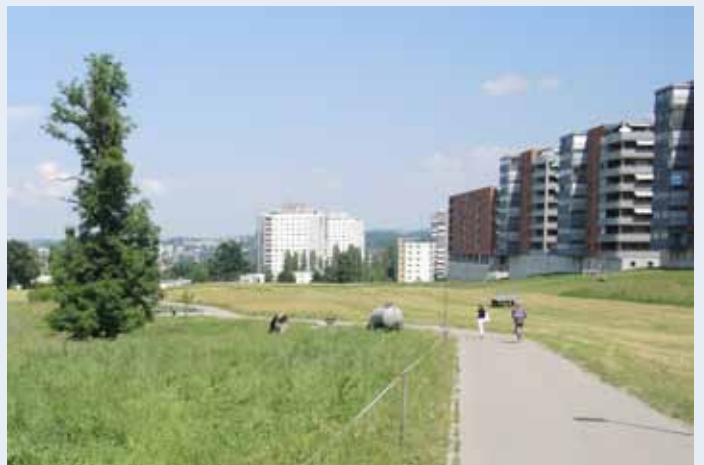
Le parc urbain de Cormanon, poumon vert et espace de délasserment, abrite aussi une liaison de mobilité douce qui relie Villars-sur-Glâne et Fribourg (photo: VsG/JMS)
