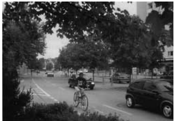
Grâce à la réduction de 6 à 2 voies, il a été possible de créer une bande cyclable confortable.
