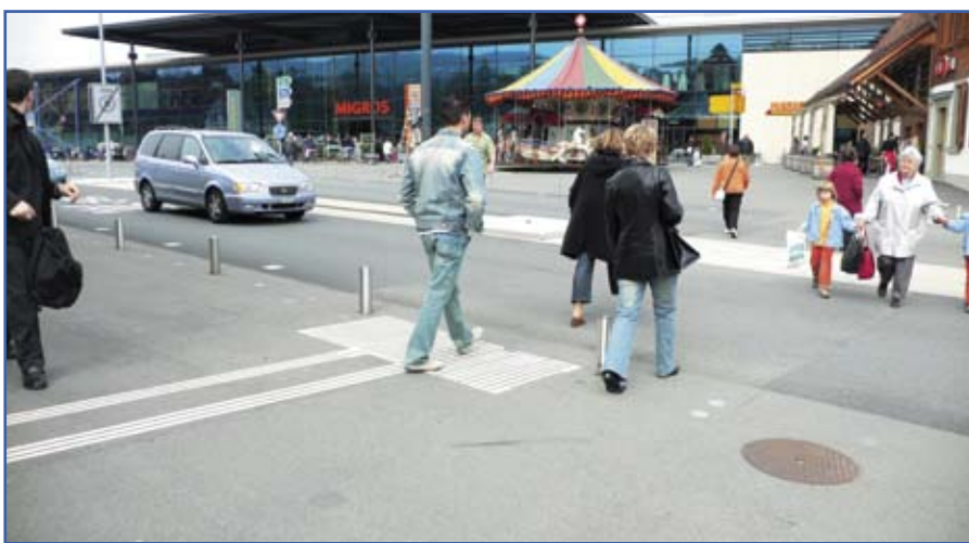
Après: des mesures coordonnées d'aménagement – giratoires aux entrées, bande polyvalente centrale – et d'abaissement de la vitesse (30 km/h) améliorent la situation de tous les usagers: les piétons, mais aussi les automobilistes et les usagers du bus (à vitesse plus lente le trafic est plus fluide et s'écoule plus rapidement).
