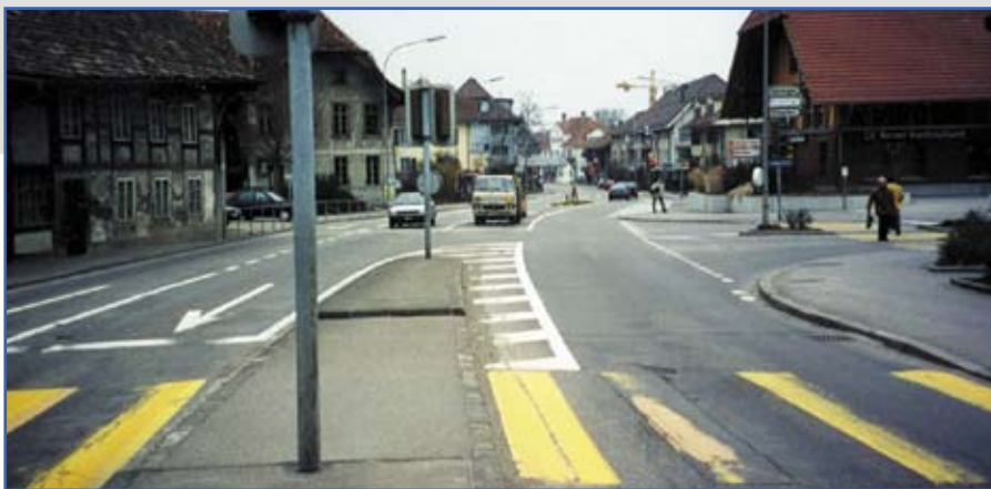
Avant: un espace dévolu essentiellement à la voiture, et des passages piétons contraignants entre lesquels les piétons traversaient de plus en plus.
